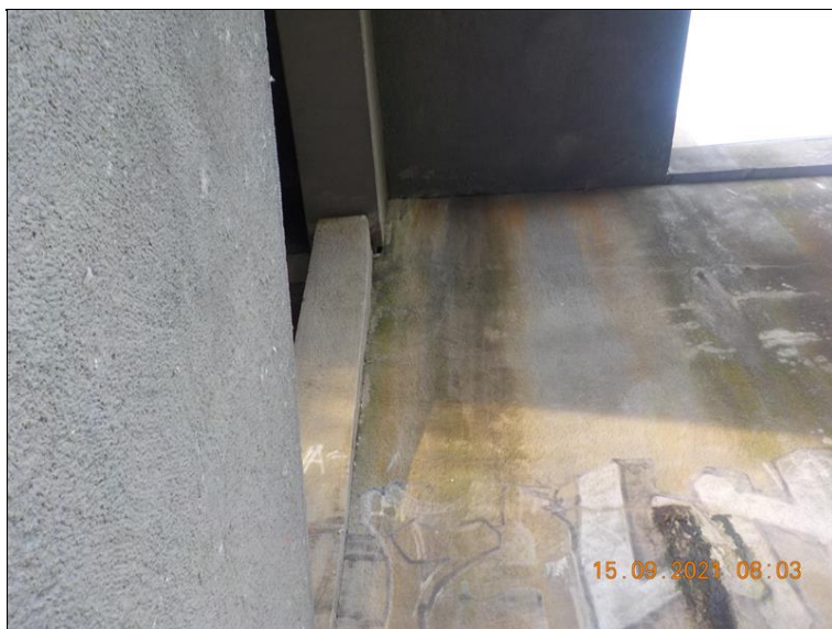
spáry křídla vlevo i vpravo mají poškozená těsnění.
