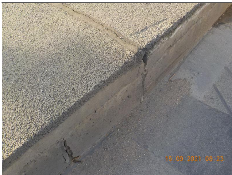
Zlom chodníku v místě dilatační spáry nad opěrou 4 vpravo.
