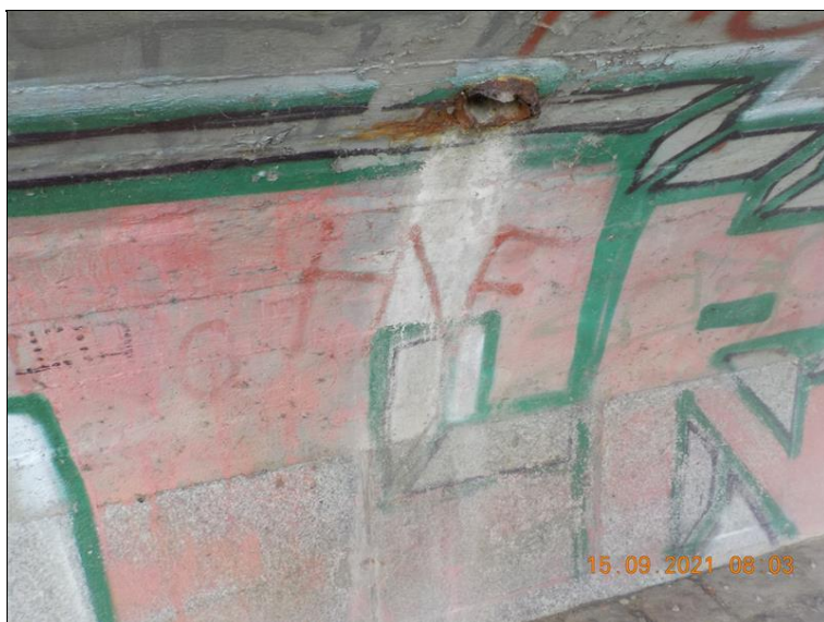
spáry křídla vlevo i vpravo mají poškozená těsnění.
