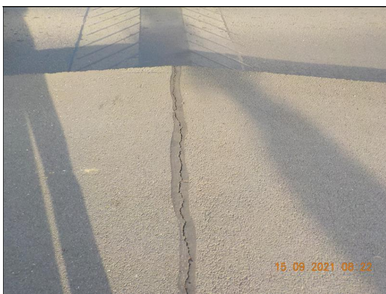
Dilatační spára a mostní závěr na opěře 4.
