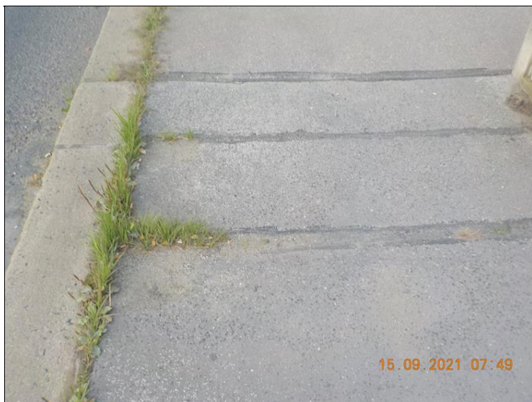
Dilatační spáry a trhliny na chodníku vlevo.
